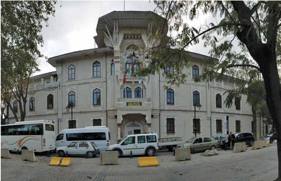
◀ Sultanahmet Meydanı'nda bulunan ve günümüzde Marmara Üniversitesi Rektörlüğü'nün kullandığı bina, Osmanlı'nın Ticaret ve Ziraat Nezareti binası idi (yanda). Binanın giriş kapısı üzerindeki Ticaret ve Ziraat Nezareti yazısı hâlâ duruyor (üstte).
